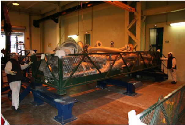
Introduction d'un ensemble d'équipements et de tuyauteries dans la presse cisaille
