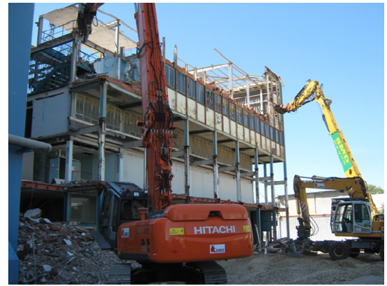
Chantier de démolition des bâtiments de commande des réacteurs
